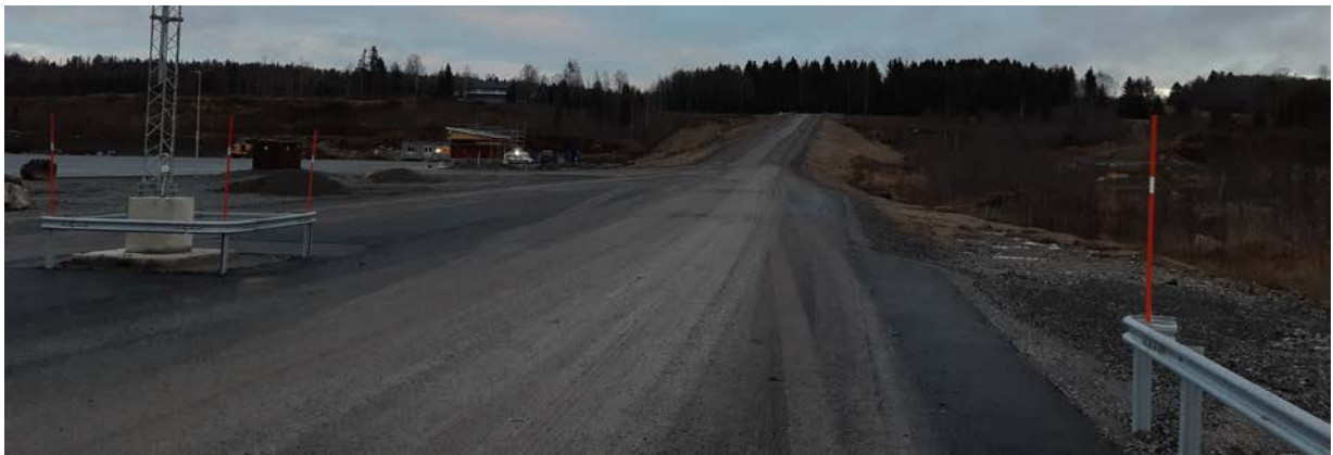
Figur 2. Infart till verksamhet från väg 684 som idag saknar stöd i gällande detaljplan d180.
